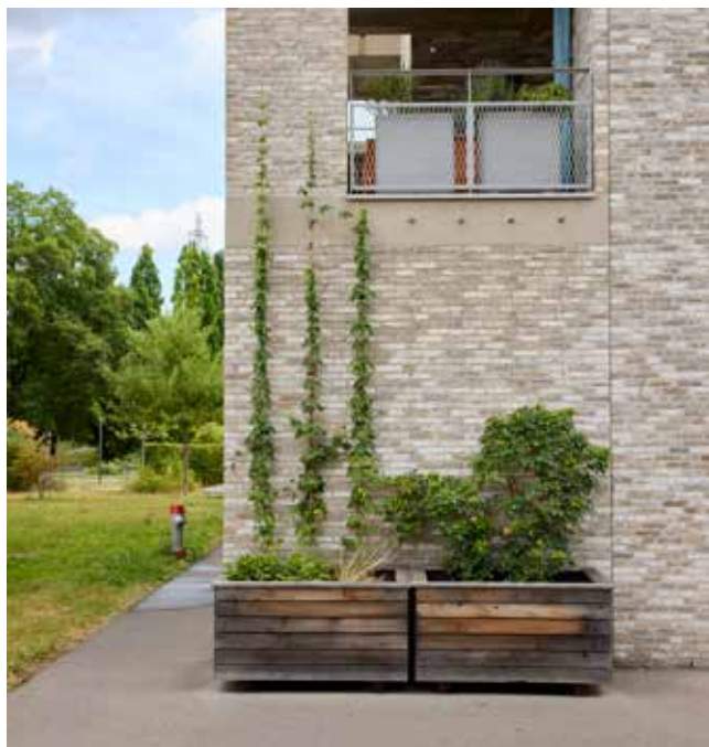
Die Siedlung Mattenhof erhält neue Pflanzen für die Fassadenbegrünung.
